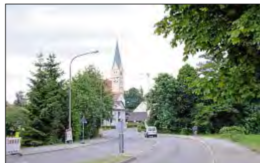
Der Kirchturm ist gerade von Baukränen umgeben.
